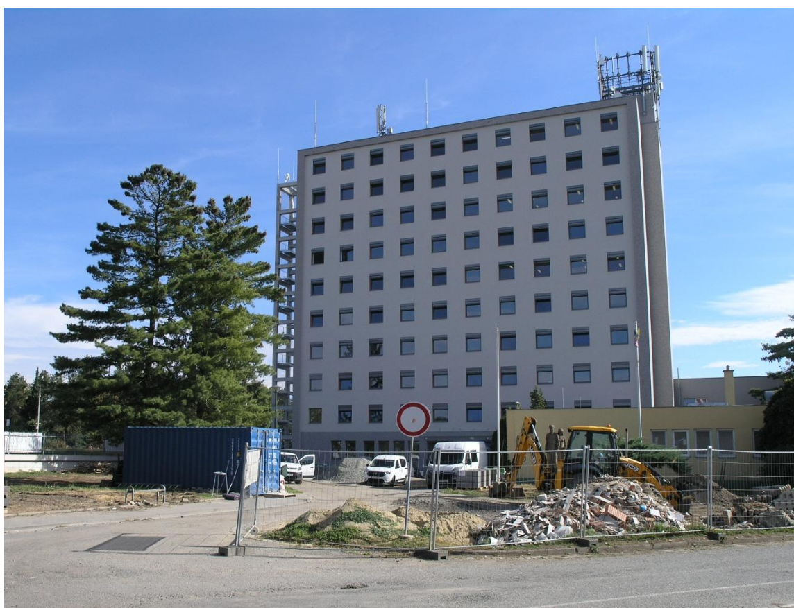
Obrázek 3 Rekonstrukce DM před dokončením
